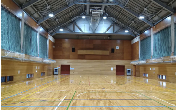
エアコン工事後体育館
