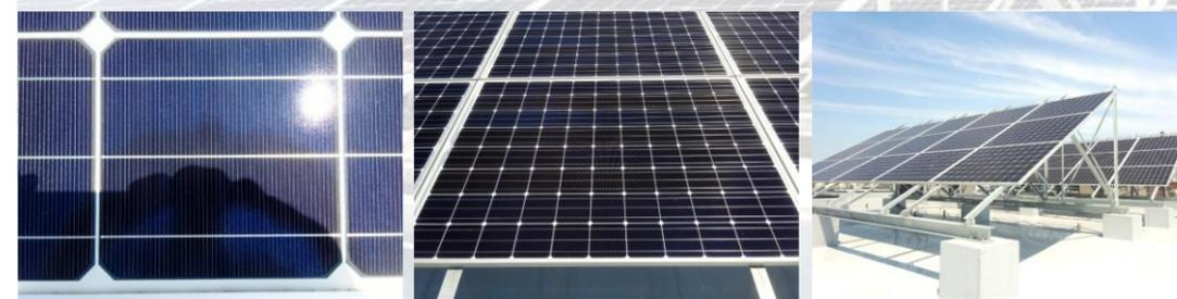
〔写真左〕単体の太陽電池を「セル」、〔写真中〕数十枚まとめたものを「モジュール」、〔写真右〕接続して配列したものを「アレイ」と呼びます。
