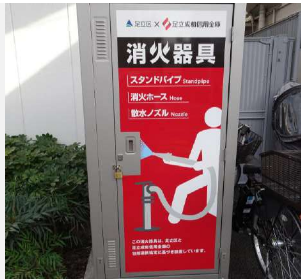
足立区との協定により、大地震の際に使用する消火器具「スタンドパイプ」の設置場所を提供しています。
