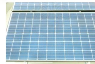
【写真上】太陽電池の単体を「セル」と呼びます。
