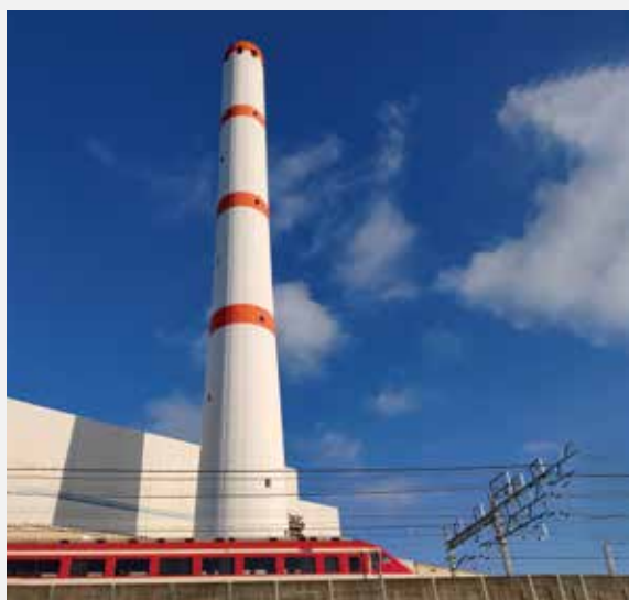
煙突からは有害物質やにおいを取り除いた排ガスを 大気に放出しています。
