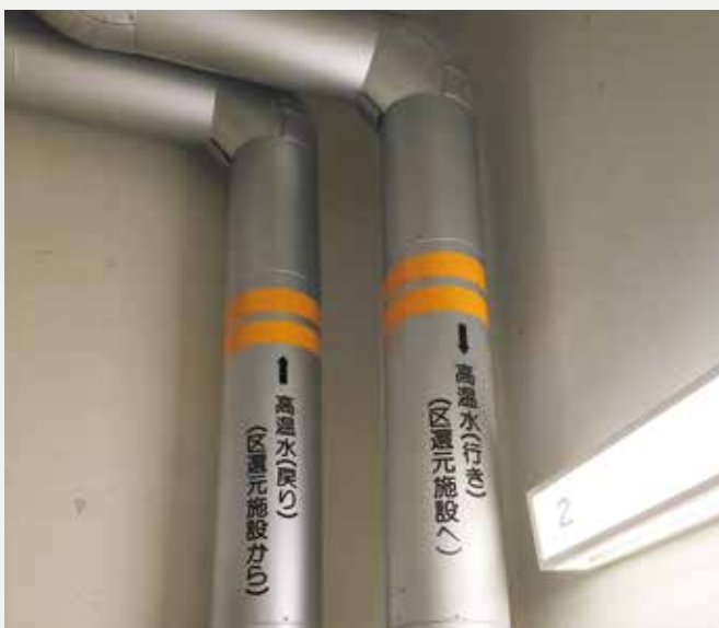
このパイプを通して隣接施設へ熱供給。
