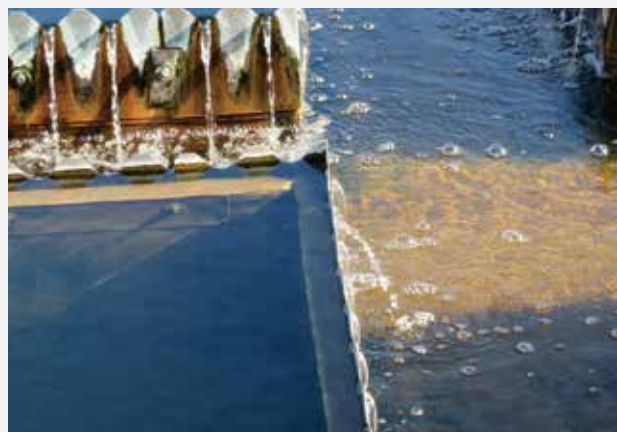
反応槽を経て、第二沈殿池の水はもう透明。
