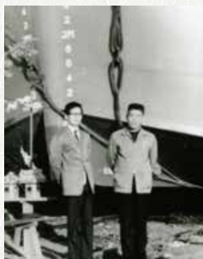
井口造船所の曳き船建造
