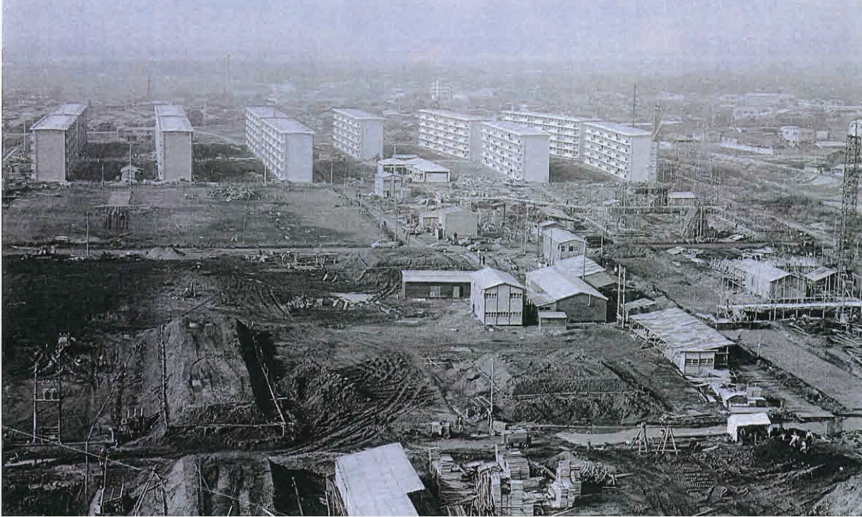
建設中の花畑団地 1963年12月
