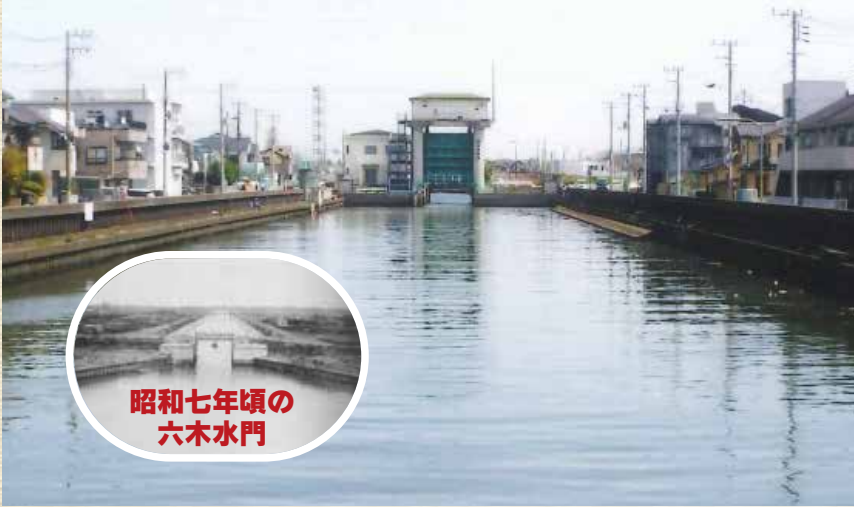
桜木橋から見た六木水門
