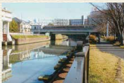
東武線の鉄橋
